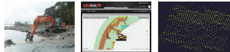
ICT 하천 준설 공사 → 시공 결과 → 시공 데이터를 그리드 데이터로 출력
